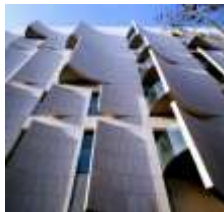
Hotel Omm (hotels/ arquitectura i interiorisme)
